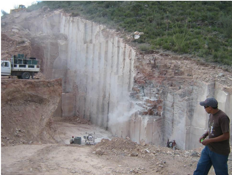
Panorámica de la explotación de bloques de ónix del banco La pedrera 3.
